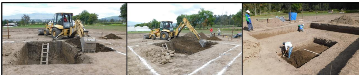
Figura 6. Extracción de capas de suelo en el bloque de lisímetros.
