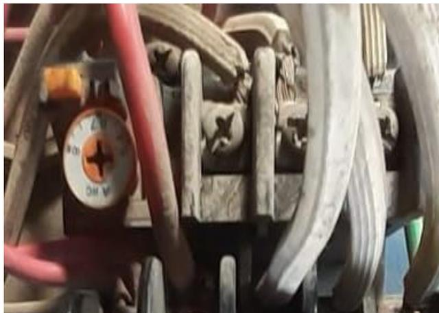
**Figura 25-3.** Relé térmico bimetálico
