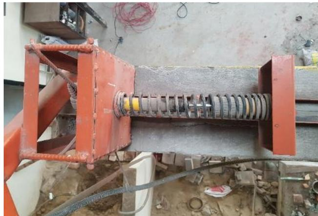
**Figura 22-3.** Amortiguador del lado suroeste
