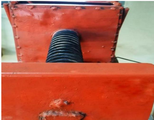
**Figura 20-4.** Amortiguador hidráulico del lado suroeste
