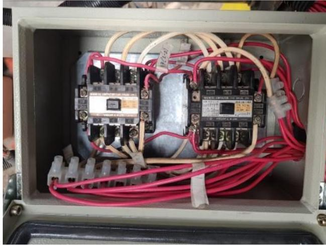
**Figura 25-4.** Contactores eléctricos
