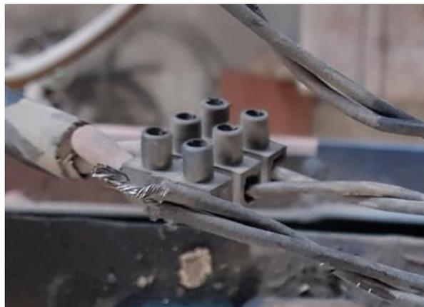
**Figura 28-3.** Borneras de unión
