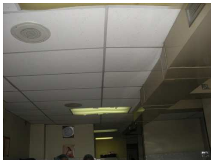
Gráfico 14: Iluminarias incompletas localizadas en el área de autoclaves
