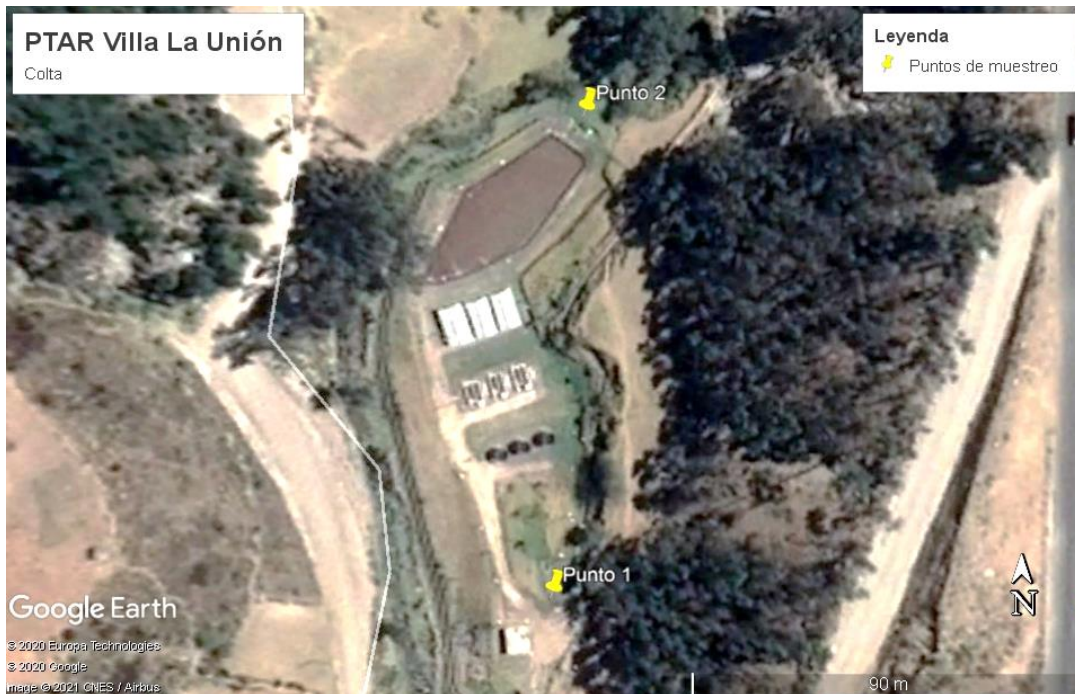
Figura 2-2: PTAR Villa La Unión
