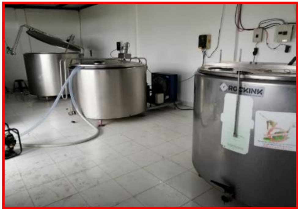
Figura: 2-5: Tanques de enfriamiento Realizado por: Carrera, Myriam. 2019.
