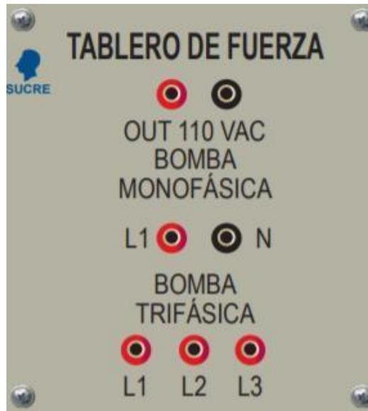
**Figura 4-5** Borneras de conexión del tablero de bombas
