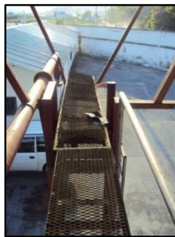
Figura 94. Falta de protección anti caída y piso irregular en la plataforma de carga.
