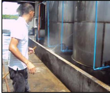
Figura 91. Peligro de quemadura con agua caliente utilizada en limpieza de pisos y tanques de semielaborados
