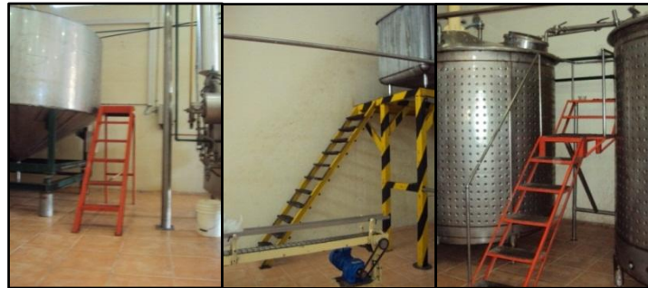
Figura 20. Escaleras con protección inadecuada.
