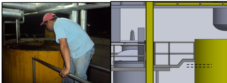
Figura 135. Acceso a tanque de crudo a modificar.
