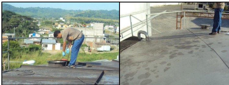
Tanque 2 sin barandal medio. Tanque 7 con grasa en su superficie.
