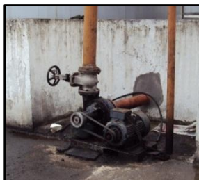
Figura 87. Bomba para la carga de tanqueros desde la plataforma.
