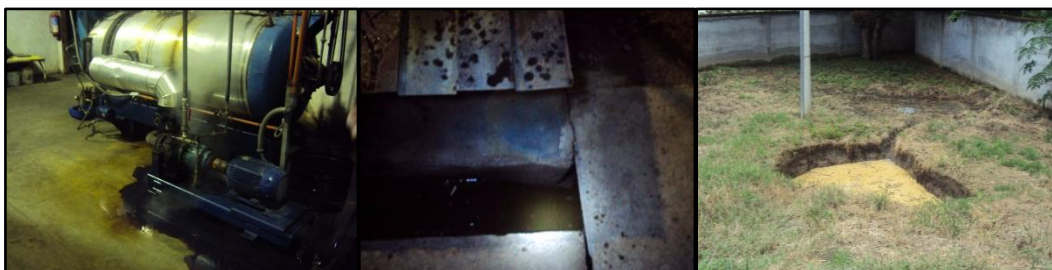
Figura 107. Derrame de aceite térmico.
