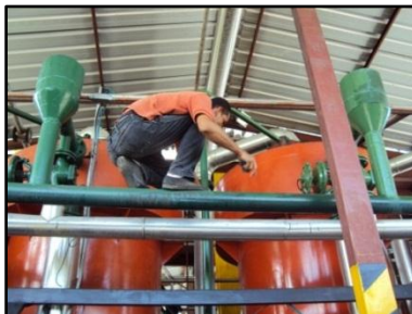
Figura 33. Trabajos en altura en fraccionamiento.
