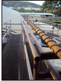
Figura 31. Tubería con venas de precalentamiento desprotegida.
