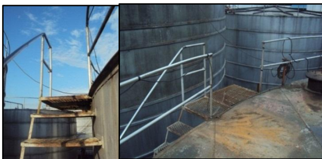
Figura 38. Escalera de tanque 1 sin barandal de seguridad.
