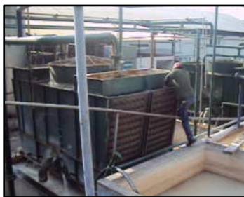
Figura 62. Falta de acceso hacia la parte superior de las torres de enfriamiento de agua.
