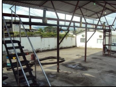
Figura 90. Estado de la plataforma para carga de tanqueros.
