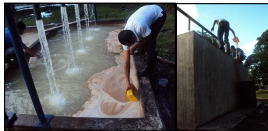
Figura 96. Piscinas de fraccionamiento sin plataforma para limpieza.
