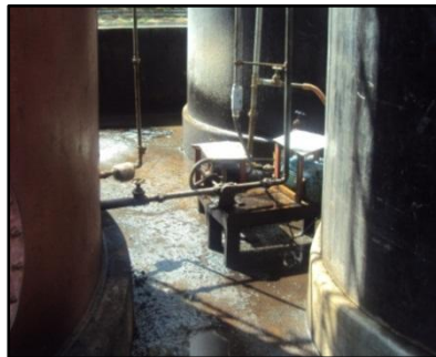
Figura 53. Unidad de bombeo con elementos móviles descubiertos en tanques de combustible.
