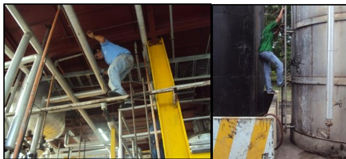
Sin acceso (Tanque - filtrado) Escalera obstruida (Tanque - ácidos grasos)
