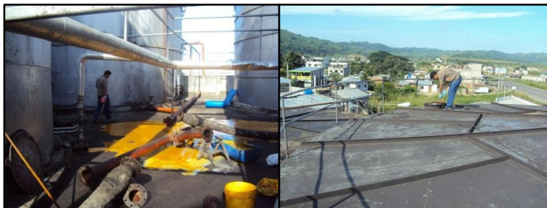
Figura 55. Obstáculos en el piso en la parte baja y superior de los tanques de almacenamiento del 1 al 7.
