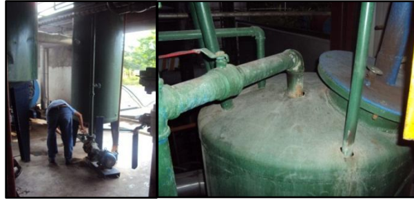
Figura 29. Peligro de caída de agua caliente en tanque 1078.
