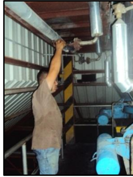
Figura 80. Línea de entrada de vapor a los filtros Niágara parcialmente descubierta.
