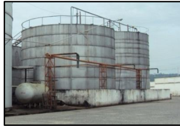
Figura 95. Zona de carga sin plataforma.
