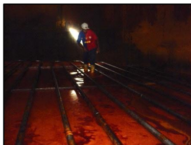
Interior de tanques de almacenamiento del 1 al 7.
