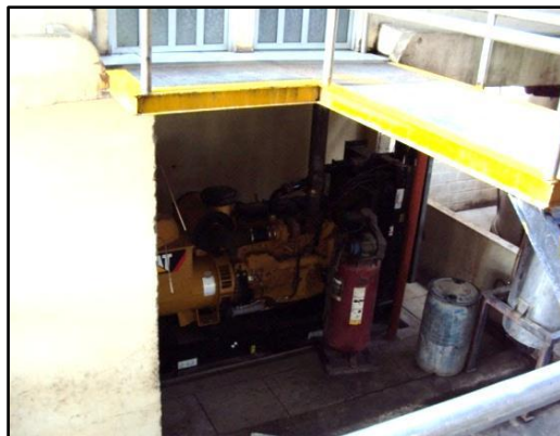
Figura 12. Ubicación actual del generador.
