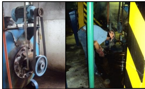
Figura 61. Elementos de transmisión de potencia descubiertos en caldera de aceite térmico.
