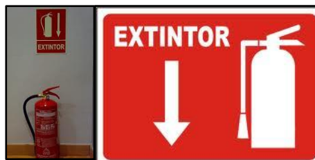
Figura 179. Señalización para extintores en pared.
