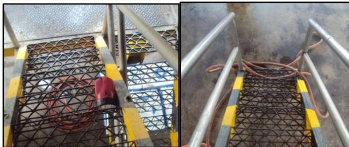
Lámpara y manguera obstruyendo la circulación en escalera.
