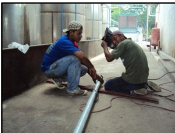
Figura 25. Falta de E.P.I.S. para operaciones de mantenimiento.
