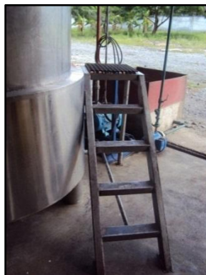
Figura 27. Escalera sin escalones antideslizantes ni barandal - fraccionamiento.
