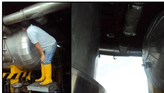
Figura 42. Peligro de proyección de líquido a temperatura en manómetro de tanque 880.
