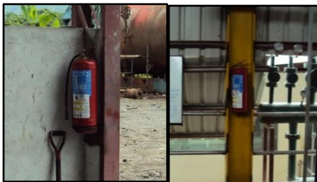
Figura 111. Falta de señalización para la identificación de extintores.
