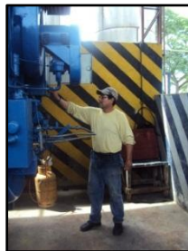
Figura 64. Recipientes a presión, área de calderas.
