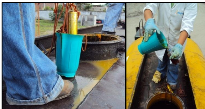
EPI inadecuado y piso resbaladizo Herramientas utilizadas.
