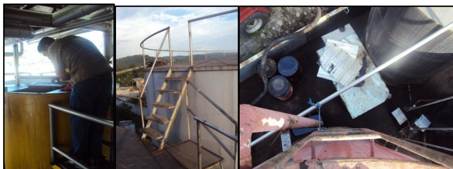
Figura 54. Accesos inadecuados frecuentes para el Bodeguero.
