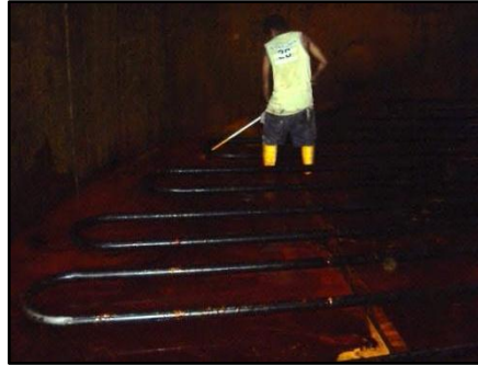
Figura 93. Peligro de caída a nivel en el interior de los tanques de almacenamiento del Ial 7.
