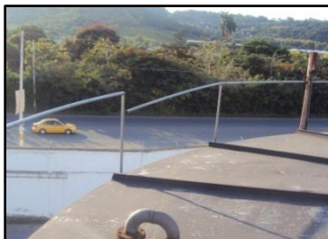
Tanque 2 con barandal defectuoso.
