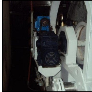
Figura 26. Moto rector para giro del filtro desprotegido.
