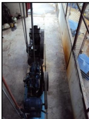
Figura 130. Compresor con elementos móviles desprotegidos.
