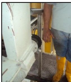
Figura 37. Elementos de transmisión desprotegidos en el tornillo dosificador de tierra.
