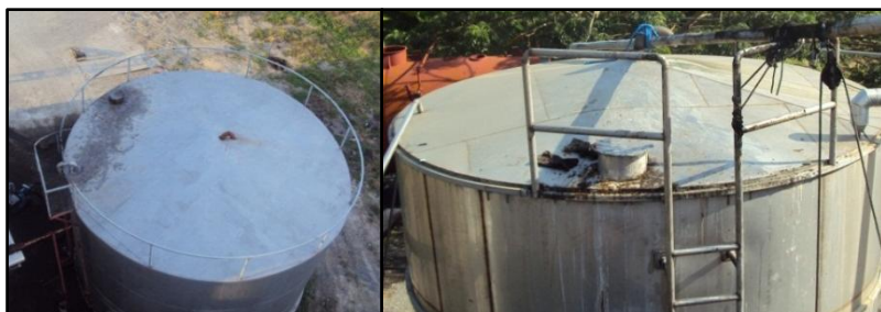
Figura 46. Trabajos en altura riesgosos por grasa en tanques 7 y Ácidos grasos.
