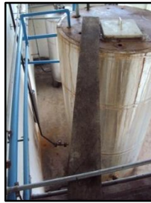
Figura 68. Acceso inadecuado hacia el tanque de agua caliente de envasado.
