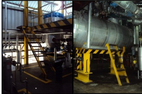
Figura 78. Escaleras hacia los filtros niágara y tanque 880 sin barandal de seguridad.
