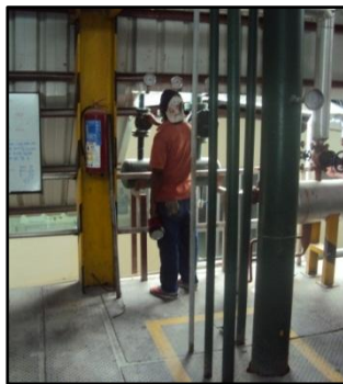
Figura 44. Líneas de agua a 85°C desprotegidas.
