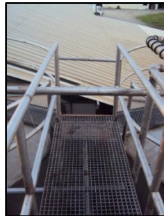
Figura 32. Tubería a baja altura obstruyendo el paso.
