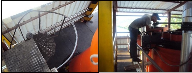
Escalera circunferencial. Toma de la temperatura de cristalizadores.
