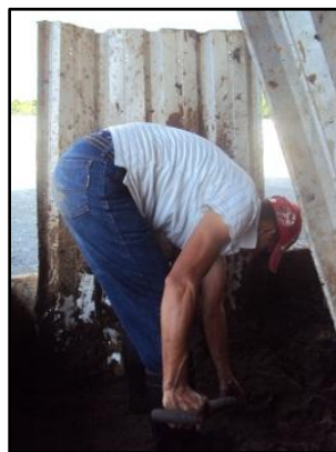
Figura 48. Riesgo ergonómico en desalajo de tierra.
