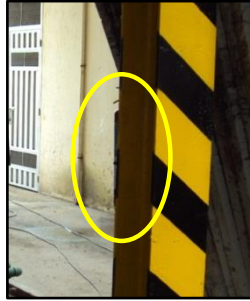
Figura 112. Extintor oculto debido a su ubicación.
