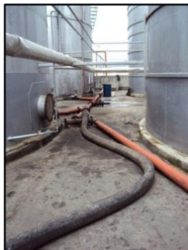
Figura 116. Orden y limpieza en tanques de almacenamiento 1-4.
