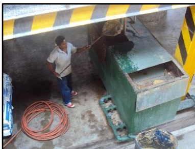
Figura 141. Manguera de uso común en refinería mal ubicada.
