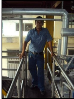
Figura 56. Tuberías a baja altura en refinería.
