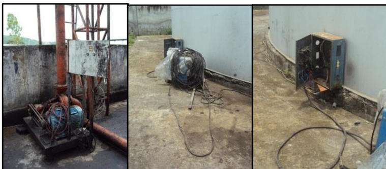
Figura 117. Equipos eléctricos al ambiente.
