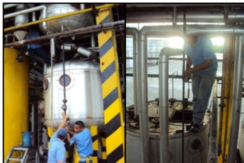
Figura 45. Trabajos en altura de grado intolerable en refinería.
