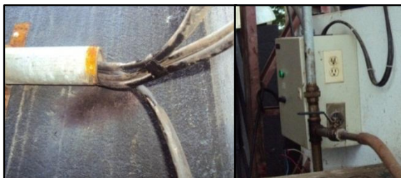
Protección inadecuada de líneas eléctricas. Ubicación inadecuada de toma corriente.
