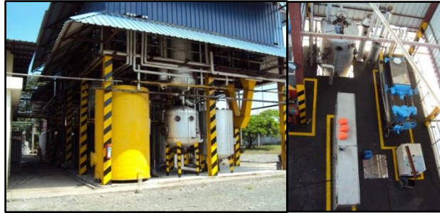
Figura 114. Señalización en Refinería.
