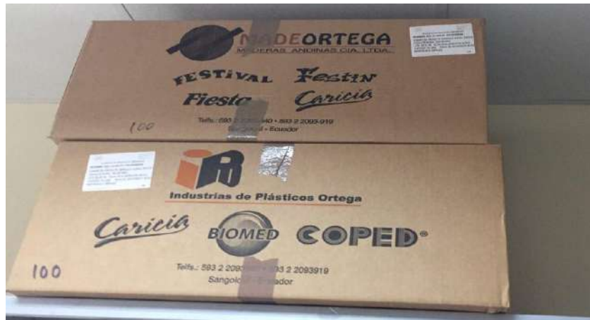
Figura 7-3: Cartones en contacto con el techo
