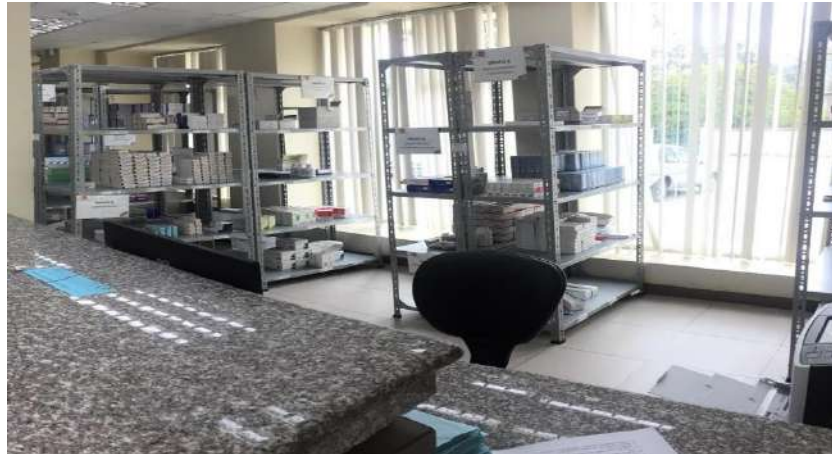
Figura 3-3: Paredes y piso del área de farmacia
