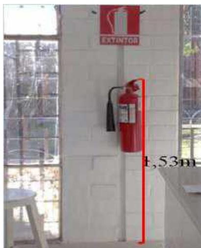
**Figura 15-4:** Altura de colocación del extintor
