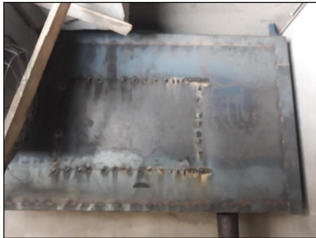
Figura 18-3: Soldadura de la tapa de desfogue del intercambiador.
