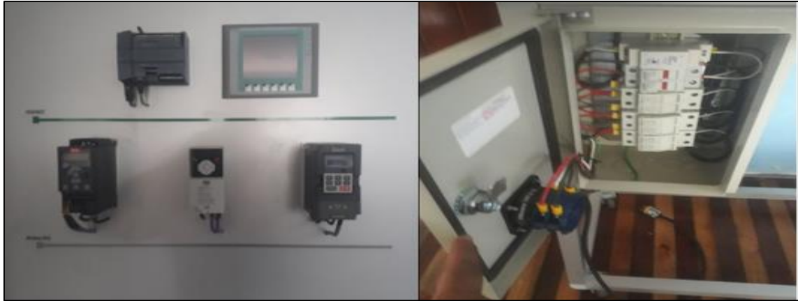
Figura 3-3: Montaje e instalación de equipos y tablero de control
