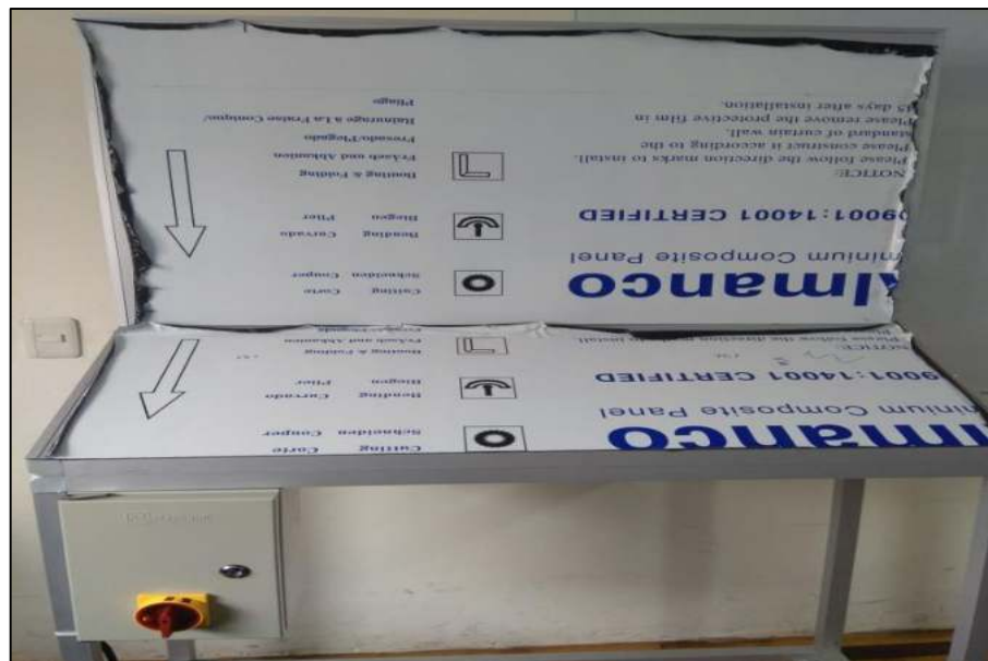
Figura 1-3: Montaje e instalación de equipos y tablero de control
