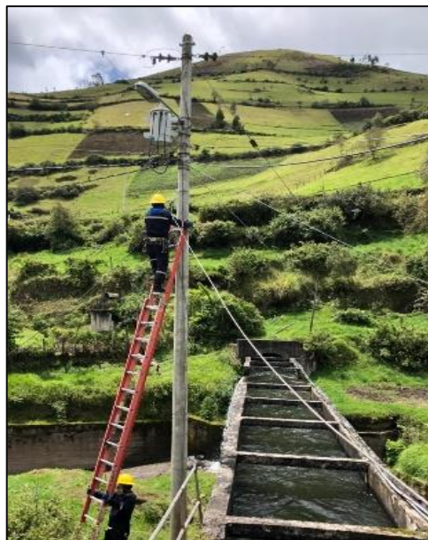
Figura 24-3: Sujeción del cable de fibra óptica
