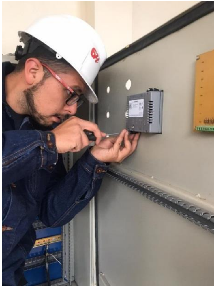
Montaje de equipos de automatización en el tablero de control
