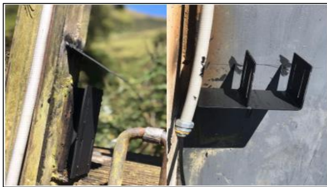
Figura 18-3: Estructura para la sujeción de los sensores
