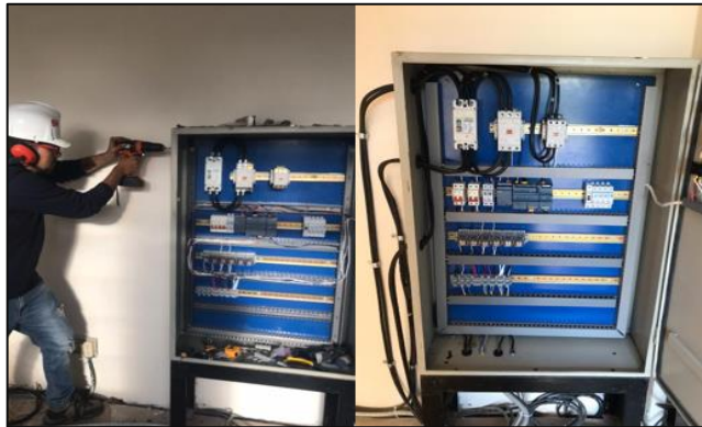
Figura 22-3: Montaje de elementos de control
