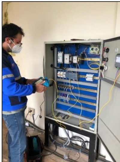
Figura 28-3: Pruebas con el OTDR
