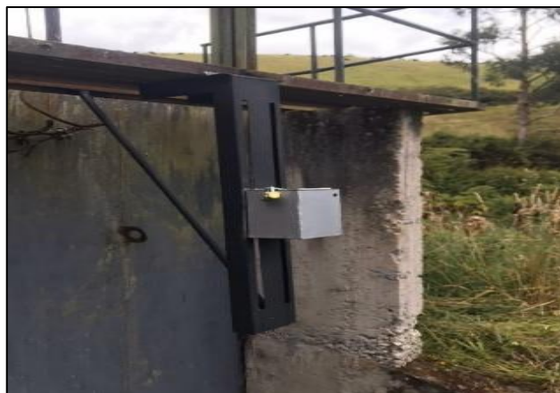
Figura 19-3: Estructura para la sujeción de los sensores
