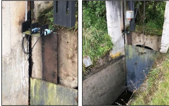
Figura 21-3: Soldadura de pletina en la compuerta Ishpi
