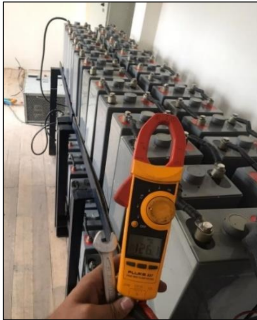
Figura 6-3: Banco de baterías. Comprobación
