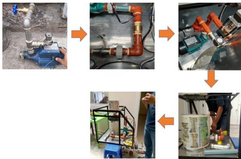
Figura 41-3 Construcción del sistema hidráulico
