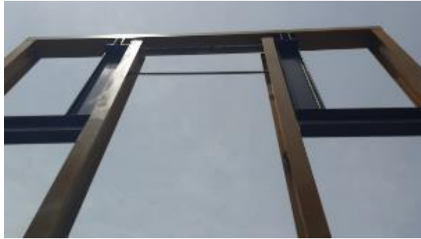
Figura 2-4: Templador colocado entre los dos brazos Realizado por: Cando Diego, García Nelson, 2020
