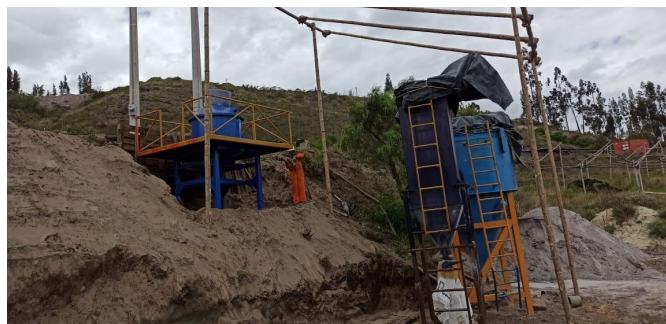
Figura 74-3. Instalación del molino al sistema de molienda
