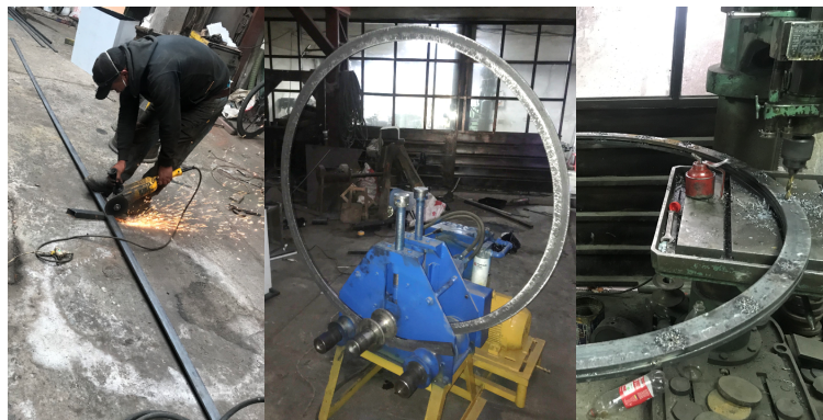
Figura 61-3. Medición, cortado, rolado y perforado de los anillos
