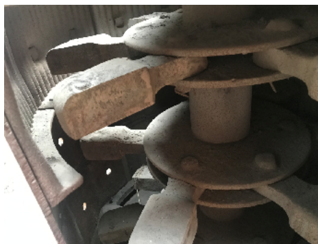
Figura 8-3. Molino con tres pisos de paletas fuera de servicio
