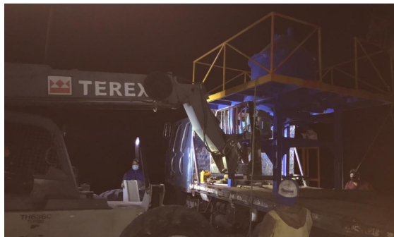
Figura 73-3. Traslado del molino a la planta de producción
