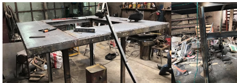
Figura 59-3. Plancha antideslizante en la estructura y reforzado de las patas
