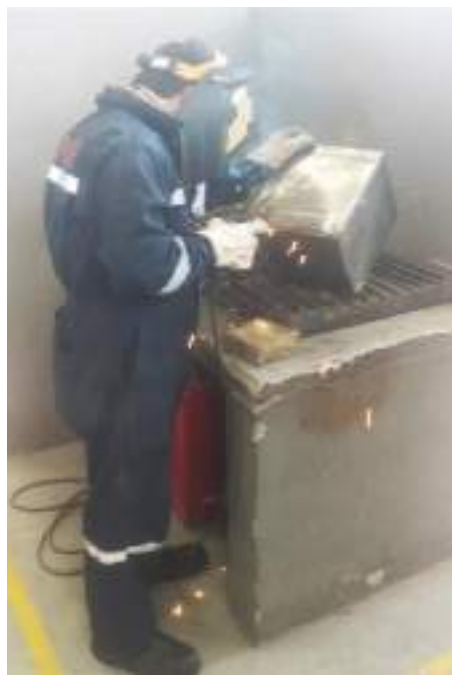
Figura 44-3. Trabajos de soldadura en la parte inferior del tanque nuevo.
