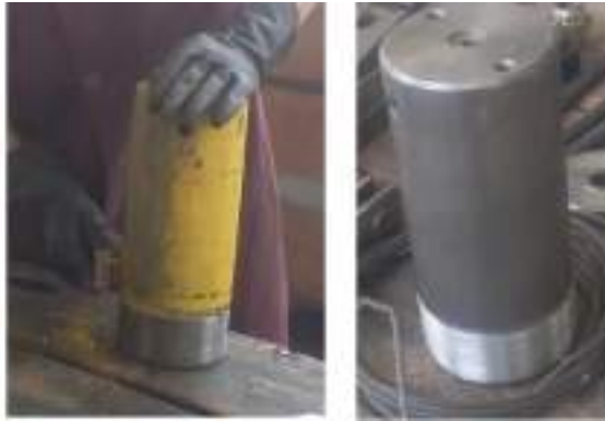
Figura 50-3. Preparación del cilindro hidráulico con SSPC-SP1 y SSPC-SP2
