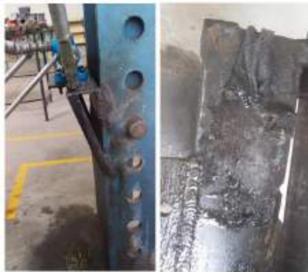
Figura 49-3. Zonas contaminadas de la prensa hidráulica
