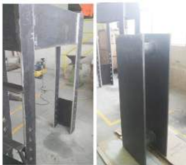
Figura 55-3. Preparación de la estructura con SSPC-SP3.
