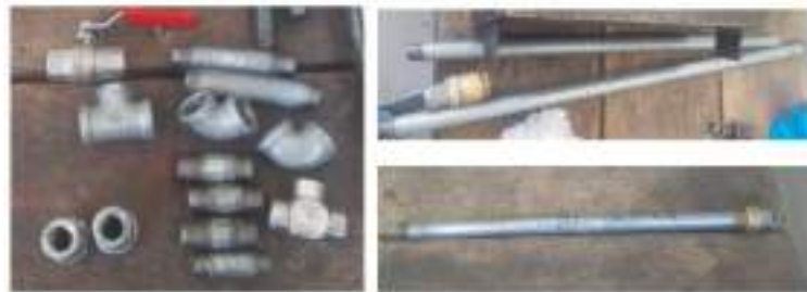
Figura 41-3. Reemplazo de tuberías y accesorios.
