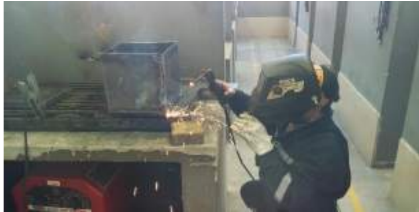
Figura 43-3. Trabajos de soldadura en la parte lateral del nuevo tanque.
