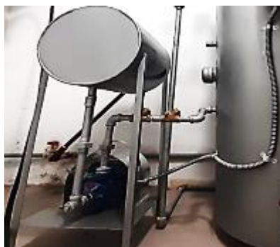
Figura 4-4: Instalación del sistema de alimentación de agua
