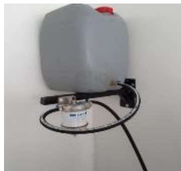
Figura 3-4: Instalación del sistema de alimentación del combustible (diésel).
