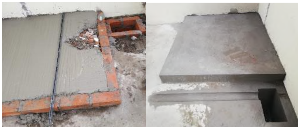
Figura 75-3: Construcción de la base para colocar el generador de vapor.
