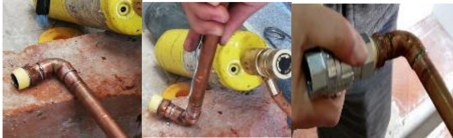
Figura 78-3: Proceso de unión de la tubería de cobre con los accesorios.
