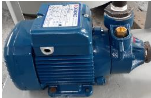
Figura 11-2: Bomba periférica de alimentación de agua PEDROLLO.
