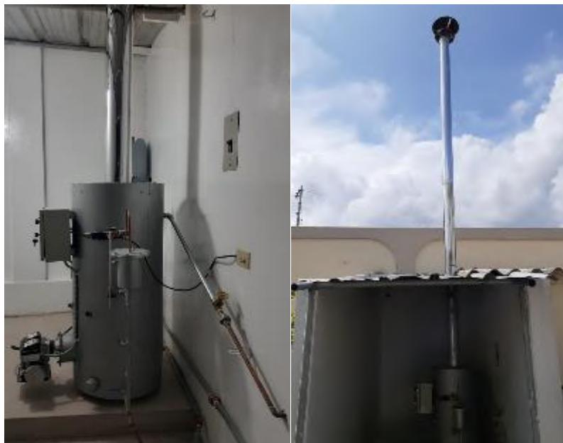
Figura 5-4: Instalación de la chimenea
