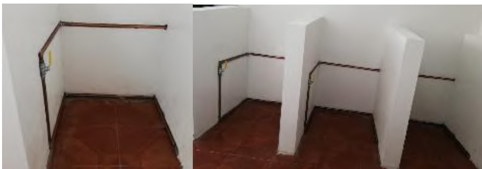
Figura 80-3: Instalación de la tubería de cobre en los cajones.
