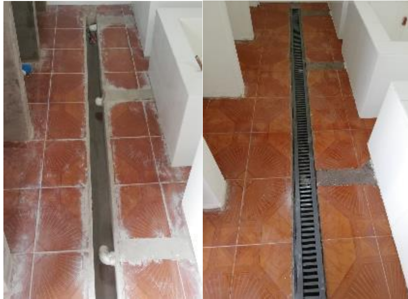
Figura 74-3: Construcción del canal para recolección de agua.
