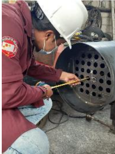
Figura 49-3: Medición de la longitud para los tubos de humo.
