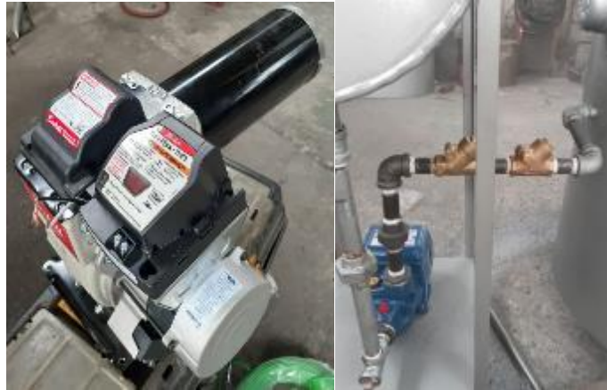
Figura 62-3: Instalación de los instrumentos.
