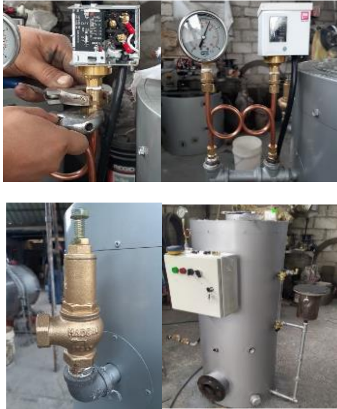
Figura 60-3: Instalación de los instrumentos.
