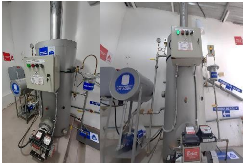
Figura 7-4: Señalética cuarto de máquinas
