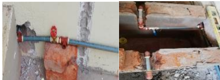
Figura 72-3: Instalación de la tubería PVC.
