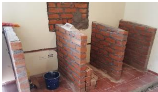
Figura 68-3: Construcción de las paredes de los baños de cajón.
