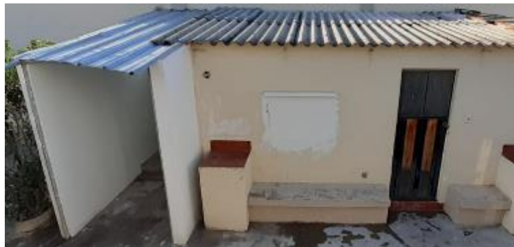
Figura 82-3: Cuarto de Máquinas.
