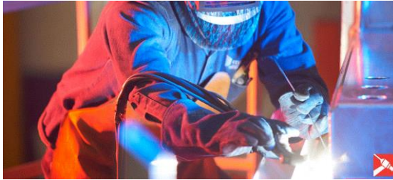
Figura 16-2: Proceso de soldadura TIG
