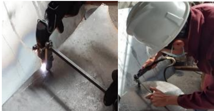
Figura 35-3: Corte del espejo inferior
