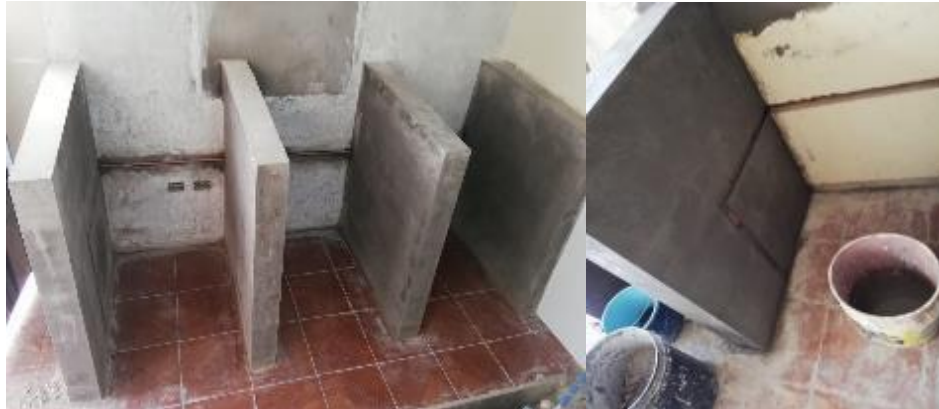
Figura 69-3: Enlucido de las paredes de los baños de cajón.
