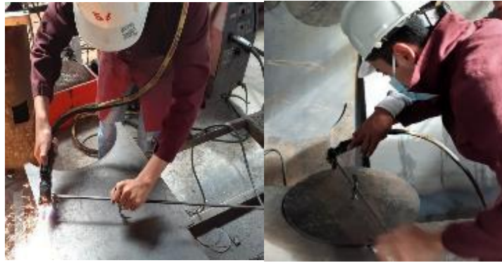
Figura 36-3: Corte del espejo superior.
