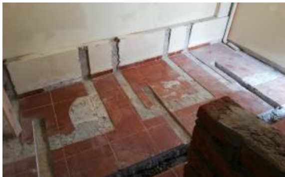
Figura 70-3: Retiro y picado de baldosas para las cubas de agua fría.
