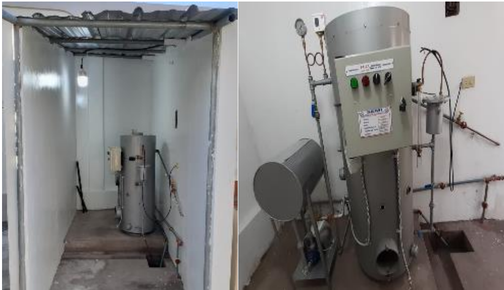
Figura 1-4: Colocación del generador de vapor e Instalación en el cuarto de máquinas.
