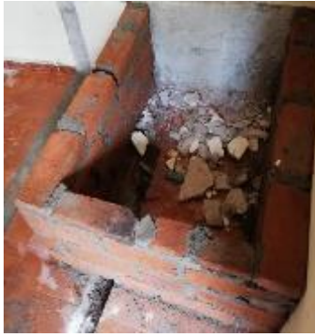
Figura 71-3: Construcción de las cubas de agua fría.
