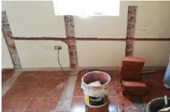
Figura 67-3: Retiro y picado de baldosas para los baños de cajón.
