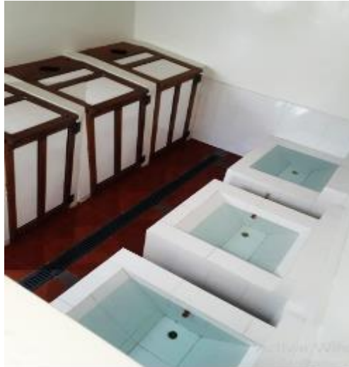
Figura 6-4: Verificación de las instalaciones
