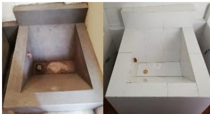
Figura 73-3: Enlucido y colocación de cerámica.
