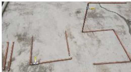
Figura 79-3: Unión del sistema de tubería de cobre.
