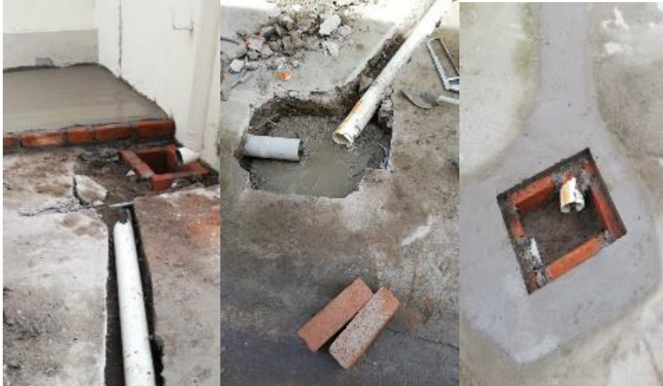
Figura 76-3: Construcción del alcantarillado.
