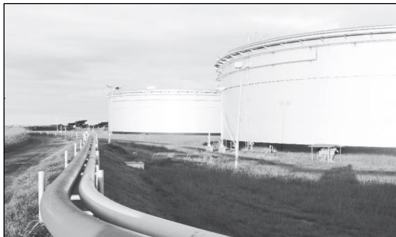
Figura 1 – 2. Tanque de almacenamiento de crudo en Lago Agrio
