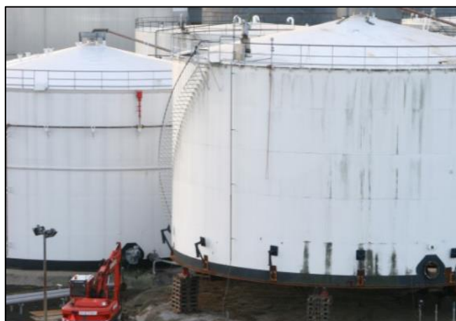
Figura 6 – 2. Tanque con techo cónico
