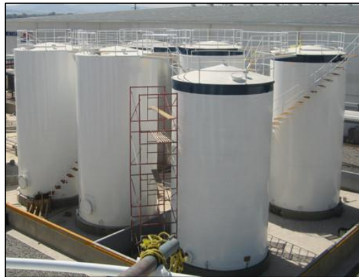
Figura 3 – 2: Tanque atmosférico
