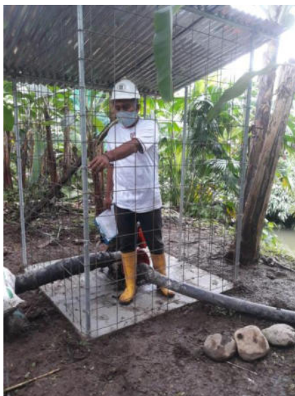
Figura 30-3: Instalación de la Bomba
