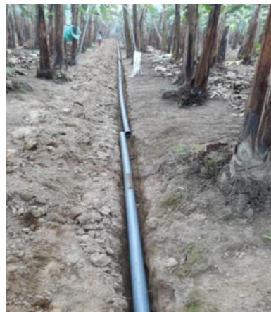
Figura 26-3: Tendido de Tubería Realizado por: Brito, J., & Tene, M. 2020
