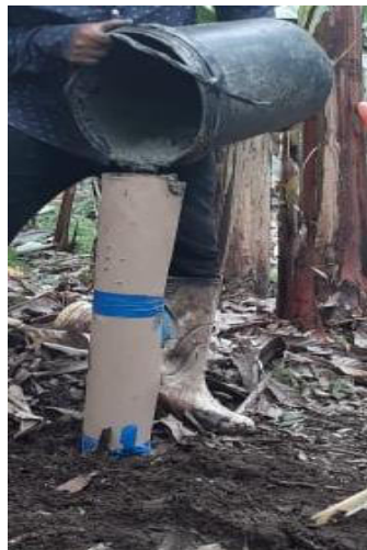
Figura 28-3: Fundición de Plintos Realizado por: Brito, J., & Tene, M. 2020
