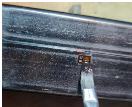
Figura 61-3: Aplicación de resina epóxica. Realizado por: Taday J., Panchi A., 2021.
