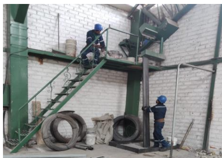
Figura 42-3: Llenado de arena previo al doblado.
