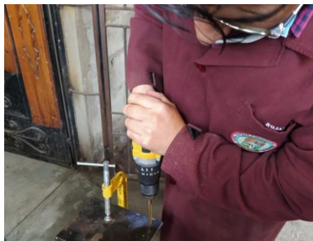
Figura 44-3: Perforado de placas base. Realizado por: Taday J., Panchi A., 2021.
