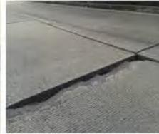
G3. Fisuras por mal funcionamiento de juntas
