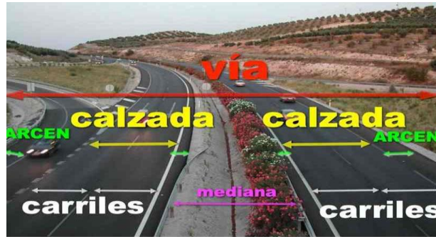
Figura 5-1. Partes de la vía
