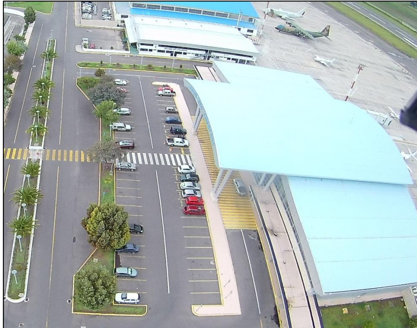
Figura 1-3: Estacionamiento ZONA N° 1
