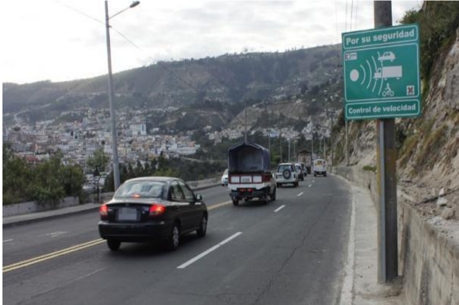
Figura 4–1: Señal indicadora de la presencia de un control de velocidad
