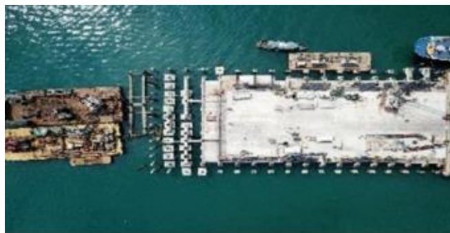
Figura 2-3: Ampliación Muelle Internacional 2
