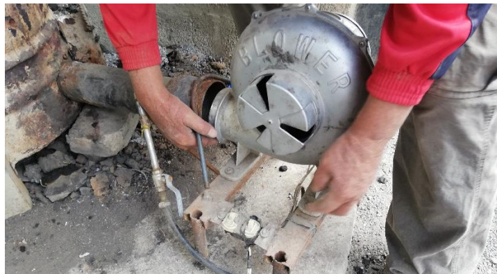
Figura 73-3: Instalación del ventilador centrífugo.
