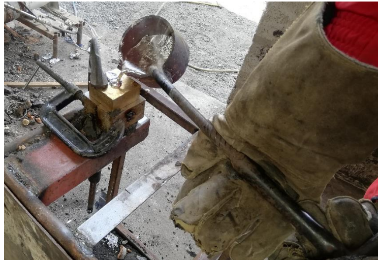
Figura 91-3: Colocación de aluminio fundido.
