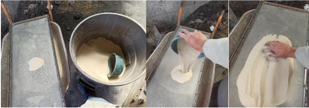
Figura 93-3: Harneado de la arena.
