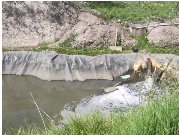
Figura 2-1. Aguas servidas en la comunidad San Vicente de Lacas
