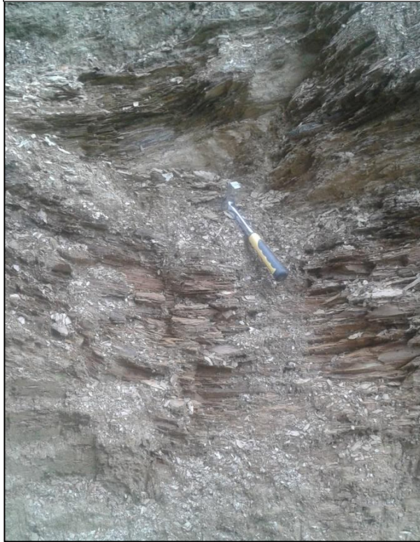
Figura 3-A. Talud de Pizarras y Filitas muy meteorizadas. (GL7).
