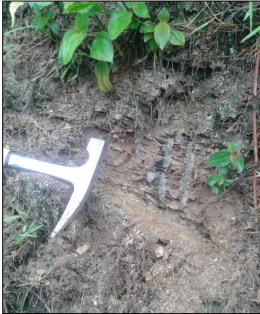
Figura 26-2. Talud de Lutitas muy alteradas por la meteorización.
