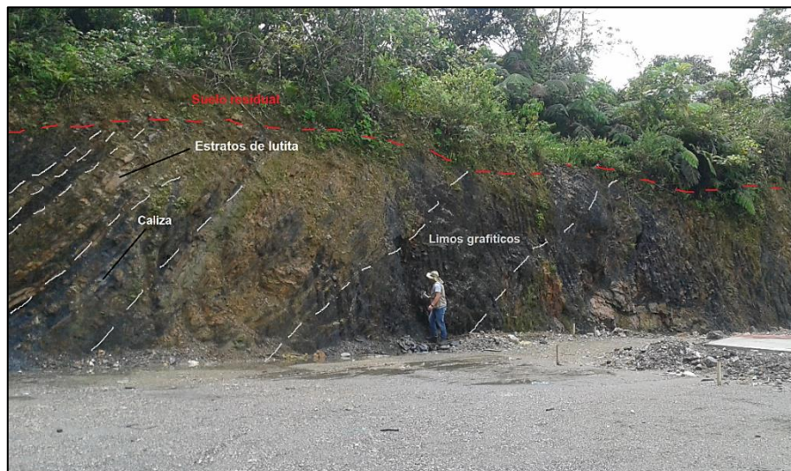
Figura 15-2. Discordancia litológica entre roca y capa de suelo.
