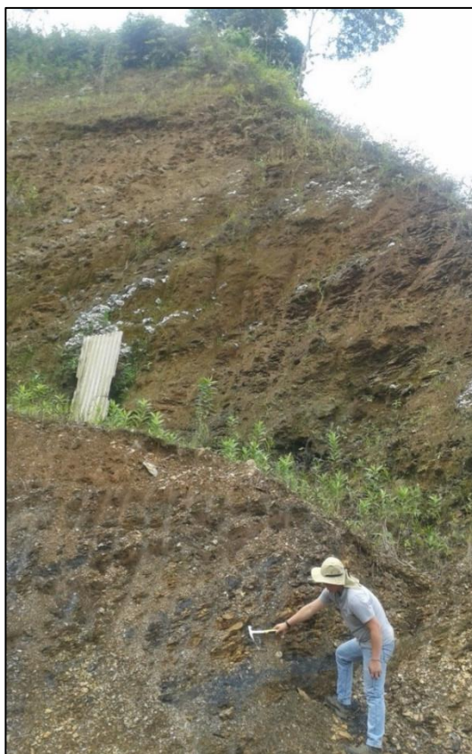
Figura 29-2. Estratos de Lutita alterada y descompuesta por la meteorización.
