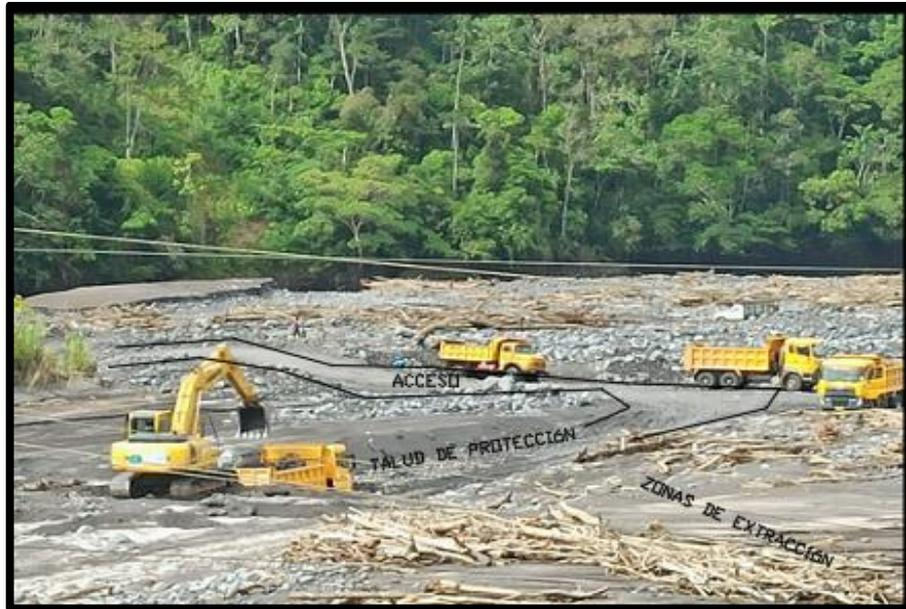
**Figura 5-4:** Implementación del método de extracción por franjas paralelas
