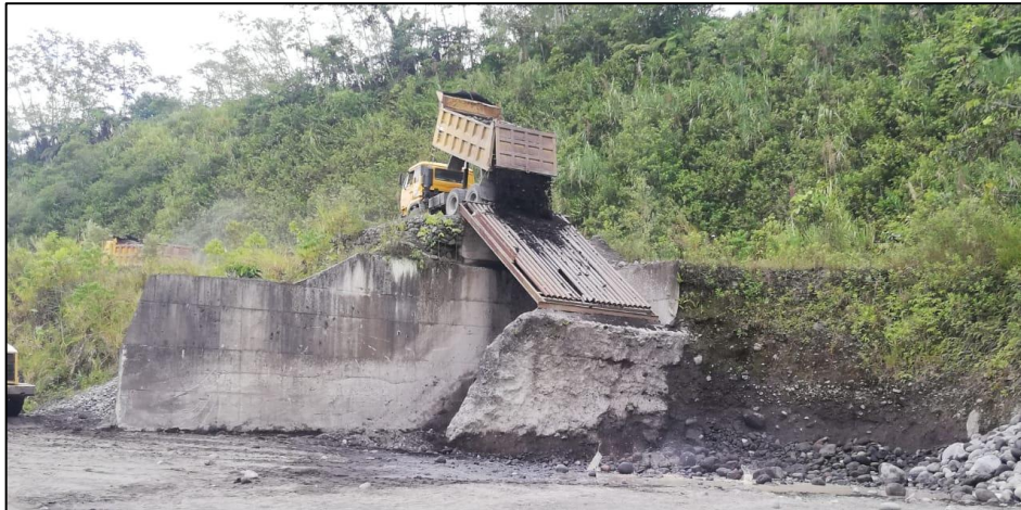
Figura 6-3: Descarga del material pétreo sobre la zaranda
