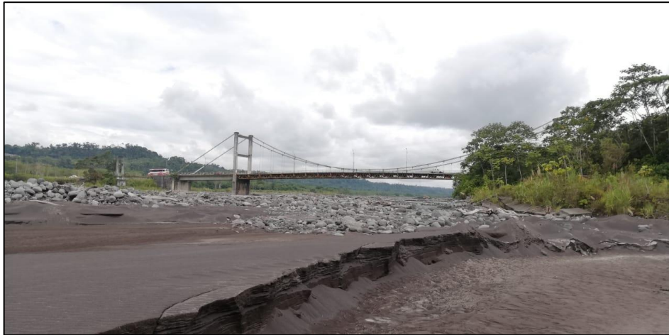
Figura 5-1: Depósito de arenas finas y grava
