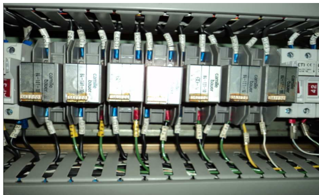
Figura VI-98. Transductores de las señales de nivel del embalse y compuertas.
