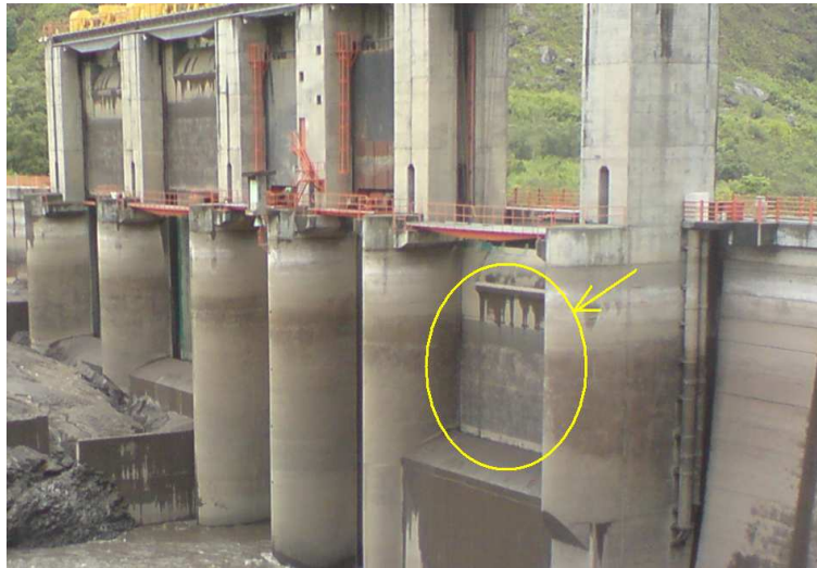
Figura III-34. Compuerta Plana del Vertedero 1.
