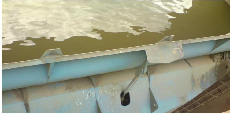
Figura III-37. Clapeta con cilindro hidráulico.
