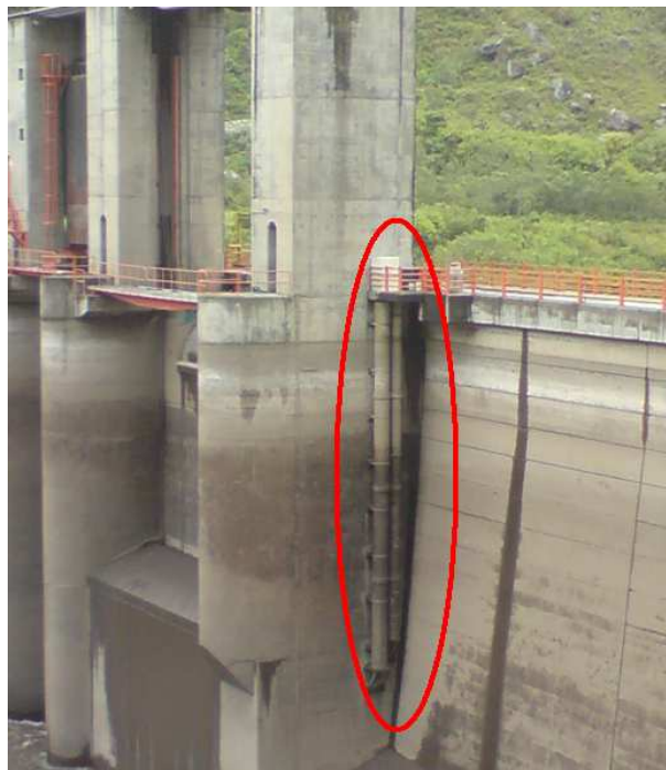
Figura III-45. Detectores de nivel del bloque 6-7
