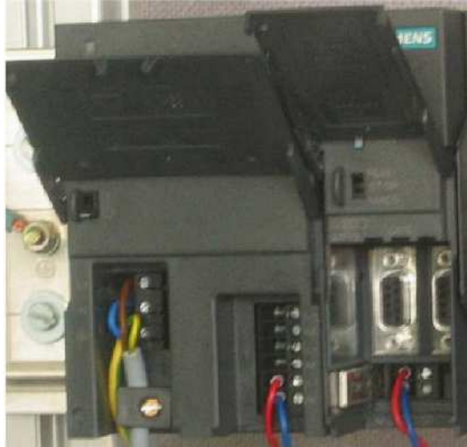
Figura IV-50. Cableado de la Fuente de Alimentación y del CPU.
