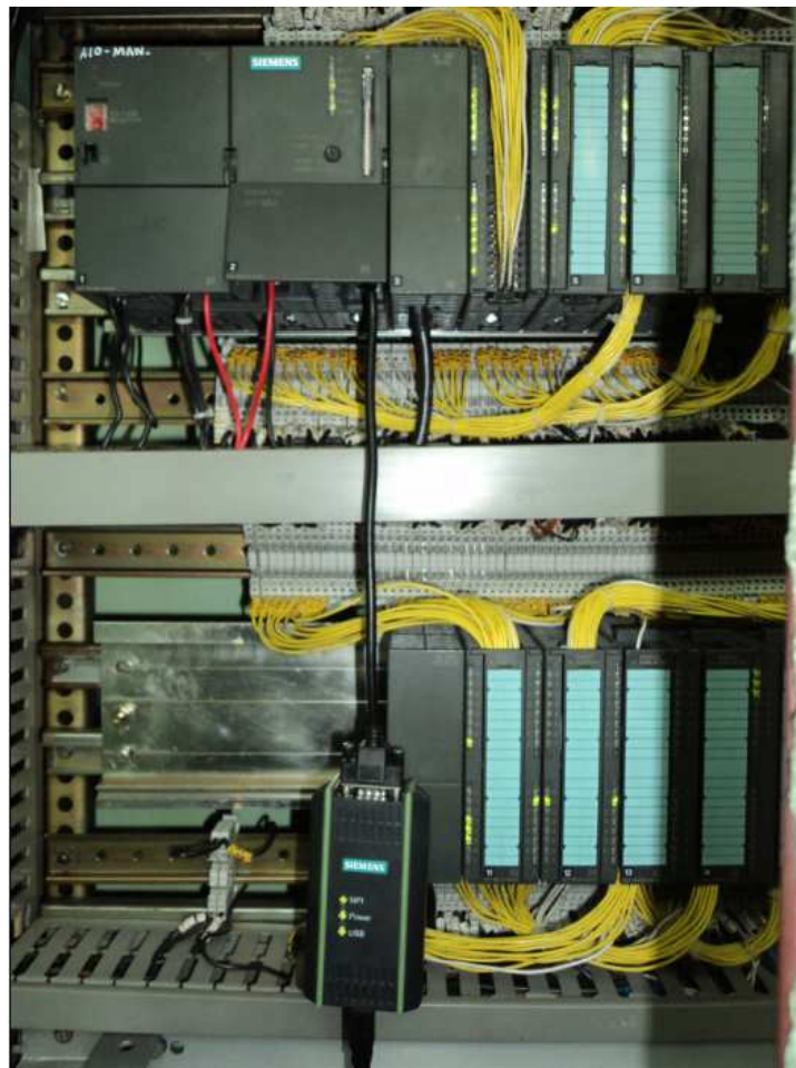
Figura VI-97. Comunicación entre PLC y HMI Runtime.
