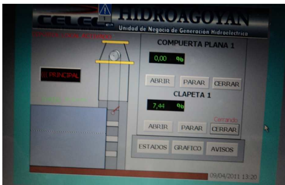
Figura VI-101. Ejecución de Cierre de la Clapeta 1.
