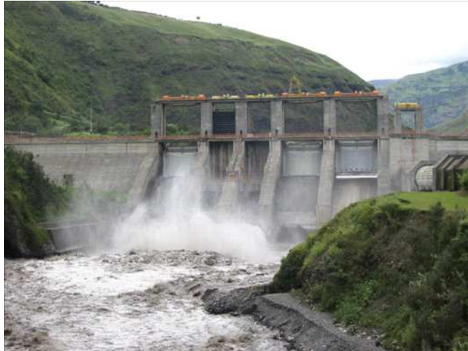
Figura III-33. Vista Frontal de la Represa Agoyán
