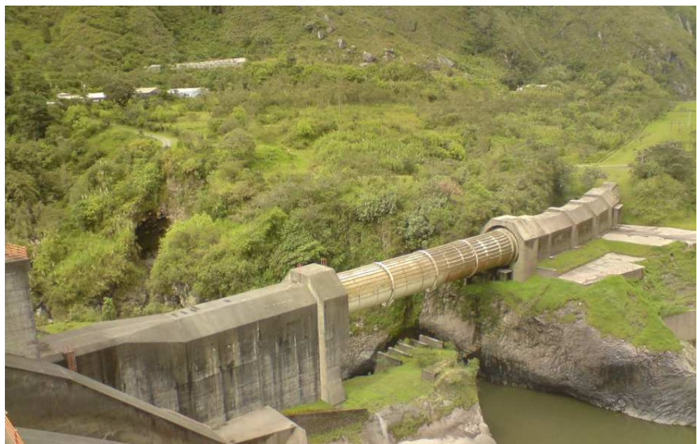
Figura III-42. Obra de Toma.
