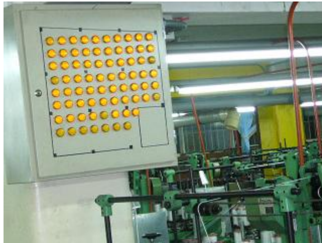
Fig. 26 Tablero de luces indicador de paros de máquina (Área de trenzado cordones)
