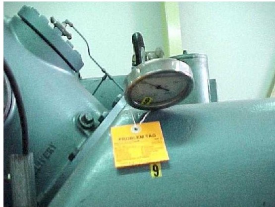
Fig.25 Manómetro con defecto
