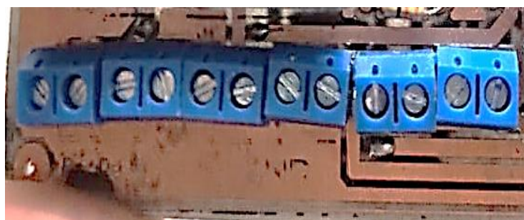
Figura 9-3: Soldadura de borneras Realizado por: Alex Paguay, Alexander Ramos. 2021
