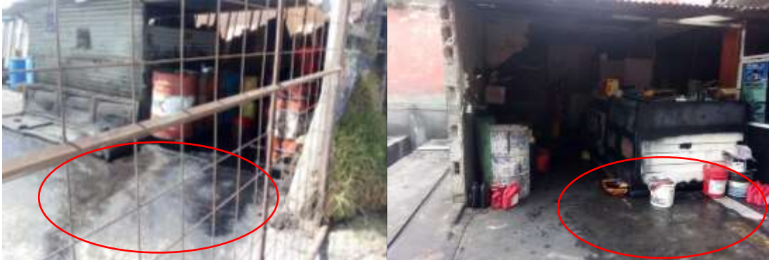
Figura 11-3: Piso de los establecimientos contaminados con aceite lubricante
