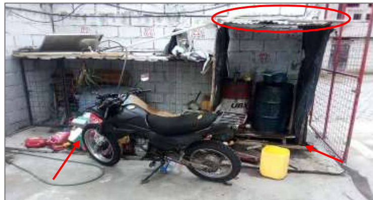
Figura 5-3: Lugar de almacenamiento con techo en mal estado
