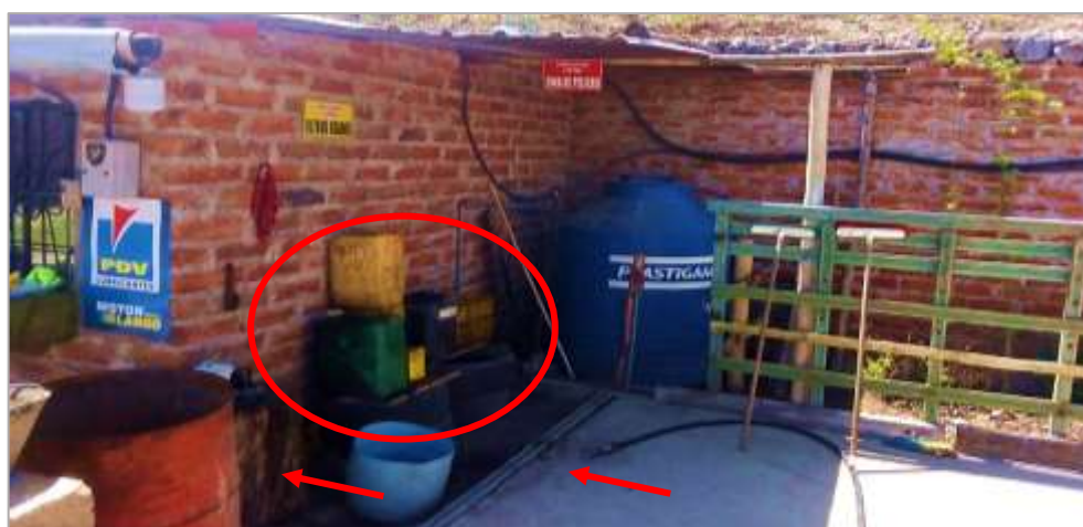
Figura 3-1: Recipientes de almacenamiento inadecuados para aceite lubricante usado
