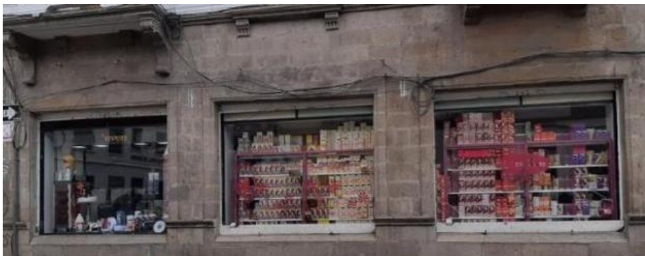
Figura 17-3: Fachada externa (actual)
