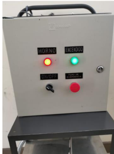
Figura 26-4. Encendido del horno. Realizado por: Guerrero, G., Arias, P., 2021.
