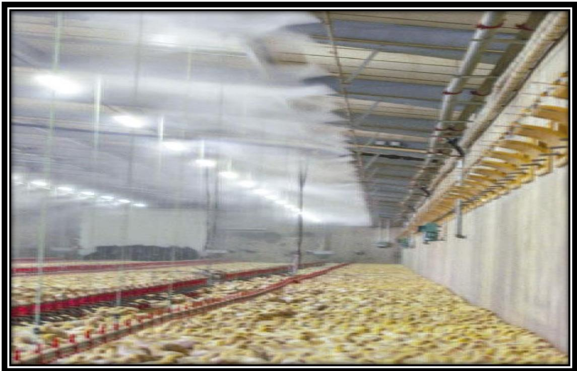
**Figura 12-1.** Sistema de nebulización usado en granja avícola tecnificada de engorde de pollos.
