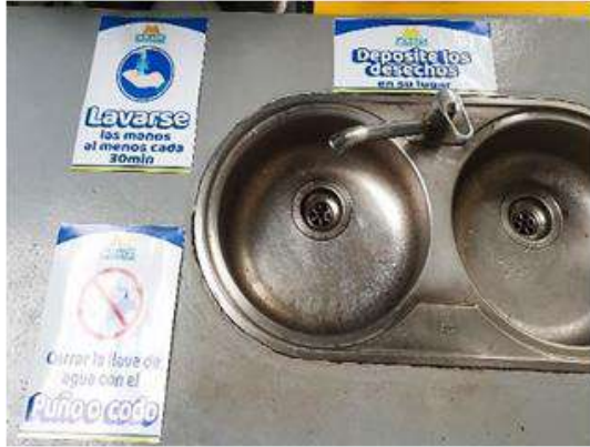
Figura 15-4. Área de lavamanos y aseo de utensilios varios
