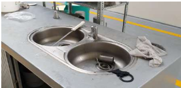
Figura 1-4. Área de lavamanos y aseo de utensilios varios
