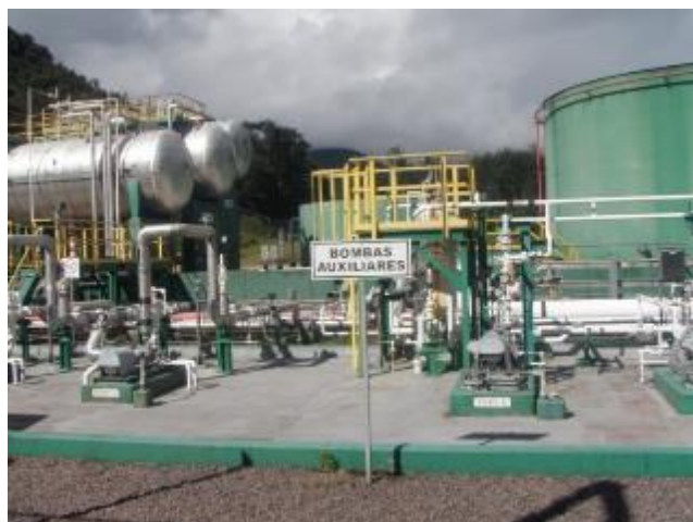
Figura 5-3: Área de la estación correctamente señalizada.
