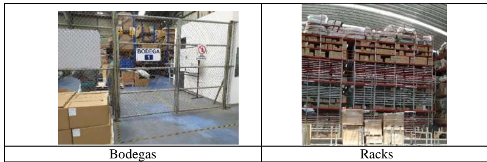
Figura 4-4. Nave de almacenamiento de CIAUTO
