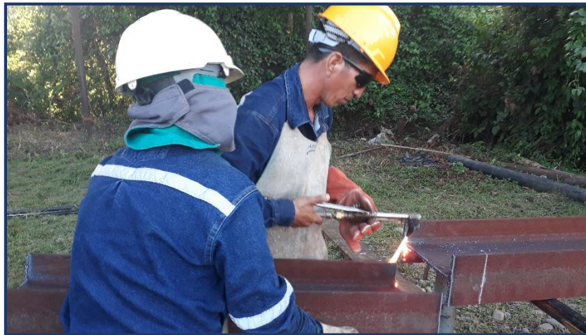
Figura 8-3: Corte de perfil IPN con soldadura oxiacetilénica Realizado por: Hernandez, Henry, 2021
