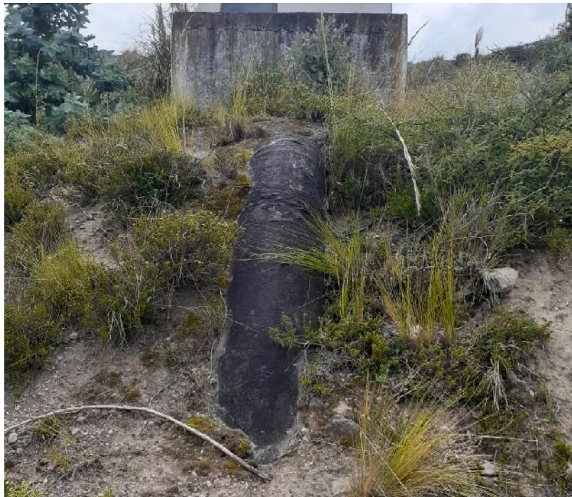
Figura 38-5. Tubería expuesta antes del medidor de Venturi del reservorio 64
