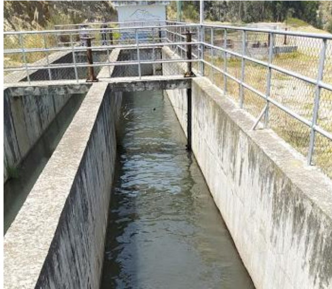
Figura 12-3. Desarenador
