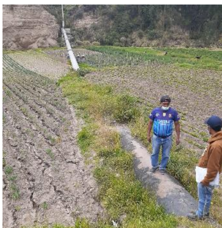
Figura 17-3. Erosión del suelo sobre tubería
