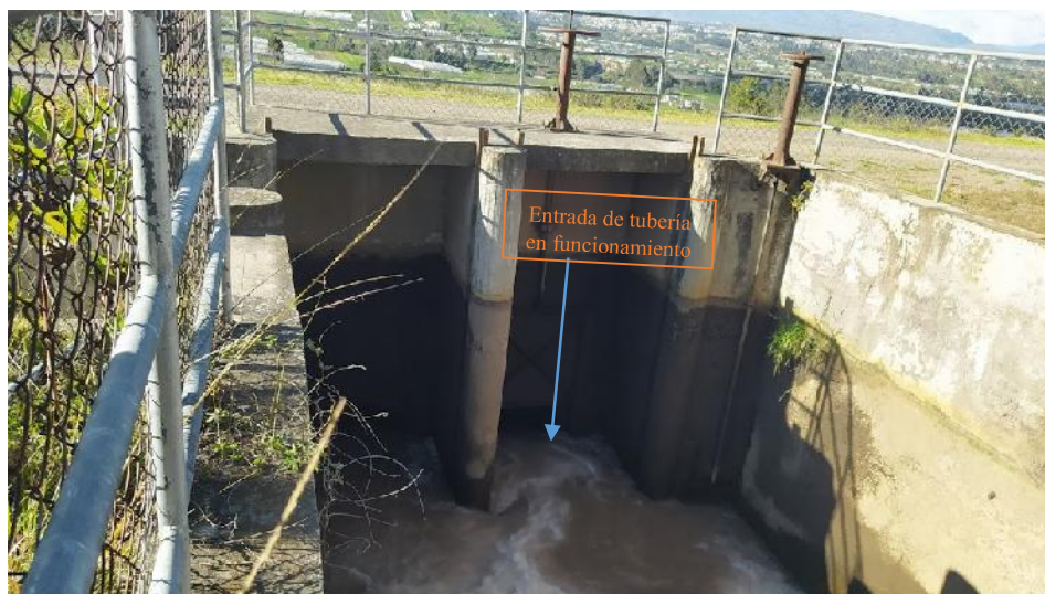
Figura 13-3. Inicio de la tubería TB11
