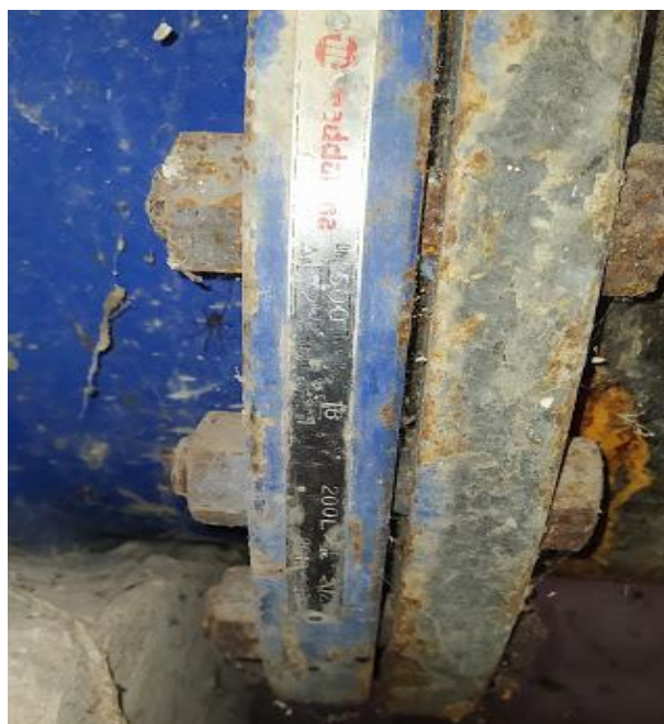
Figura 29-3. Placa de datos técnicos de un medidor de Venturi
