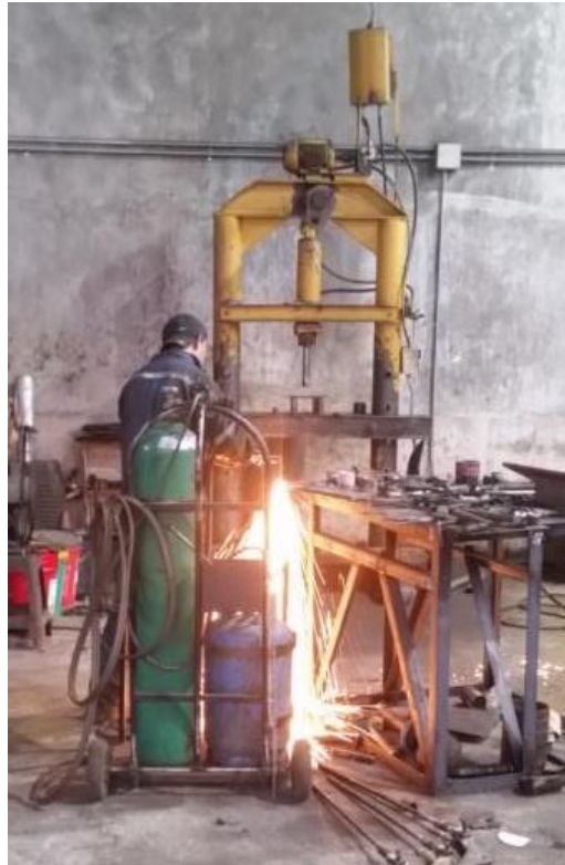
Figura 20-3. Falta de protección de material particulado
