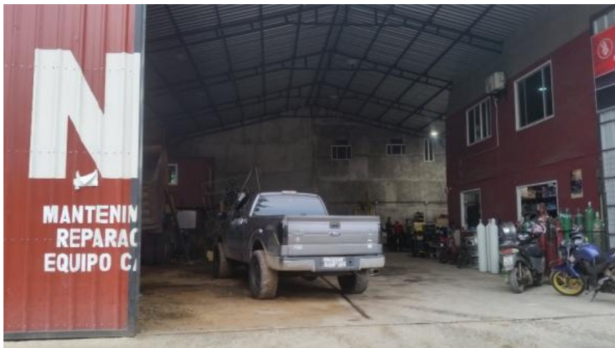
Figura 4-3. Área de recepción
