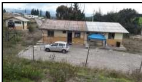
Figura 1-4. Centro de Salud de la parroquia San Isidro de Patulú.
