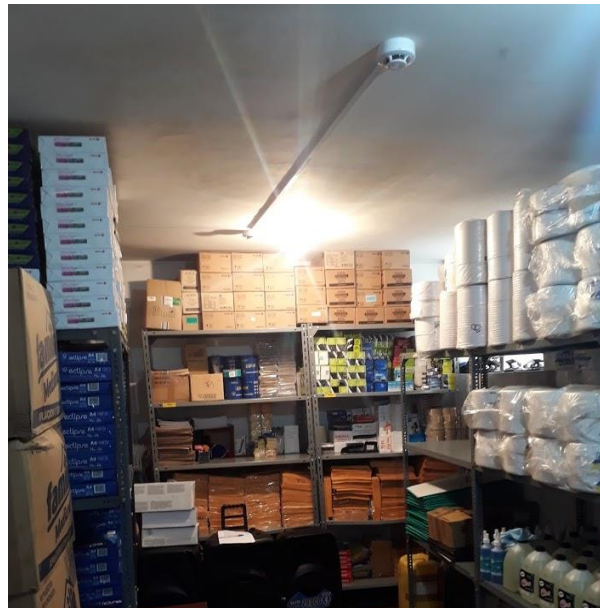
Figura 7-3: Detector de humo.
