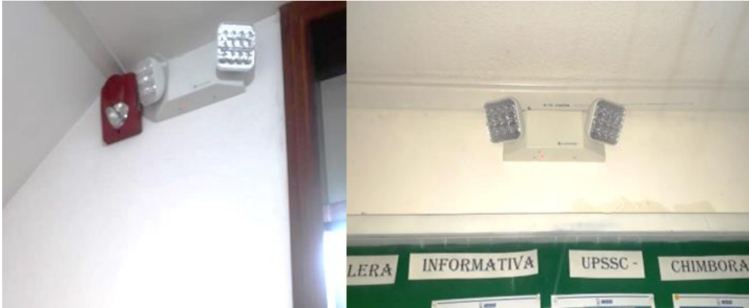
Figura 5-3: Lámparas de emergencia.
