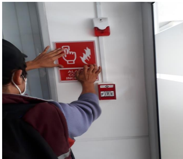
Figura 33-3: Colocación señales de equipos contra incendio.
