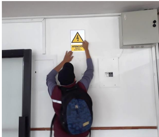
Figura 32-3: Colocación señales de precaución.
