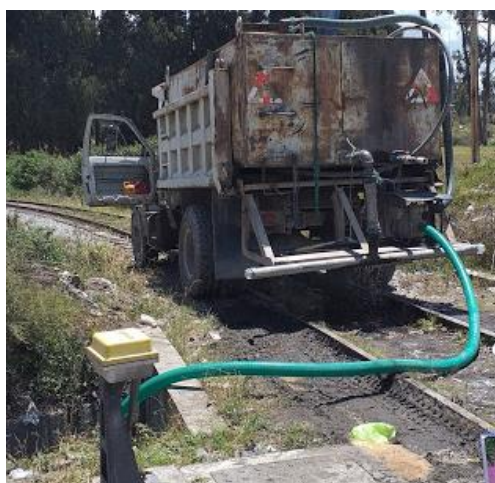
Figura 8-4: Abastecimiento de agua a la cisterna de almacenamiento
