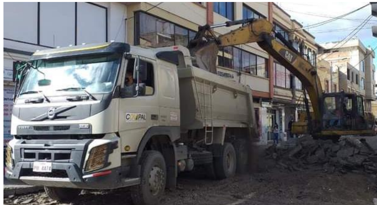
Figura 3-4: Trasladar los escombros producidos por el retiro de la carpeta asfáltica antigua
