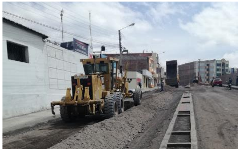
Figura 4-4: Nivelación del suelo
