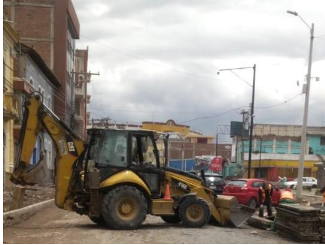
Figura 2-4: Transporte de tableros de metal
