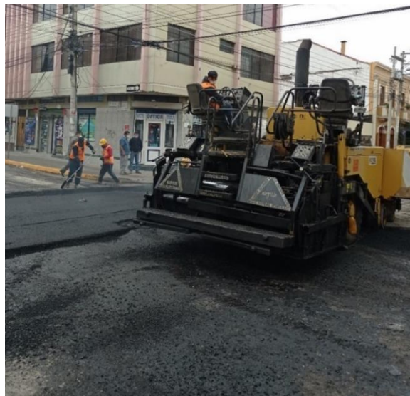
Figura 10-4: Manejar y operar la extendedora de asfalto Finisher.
