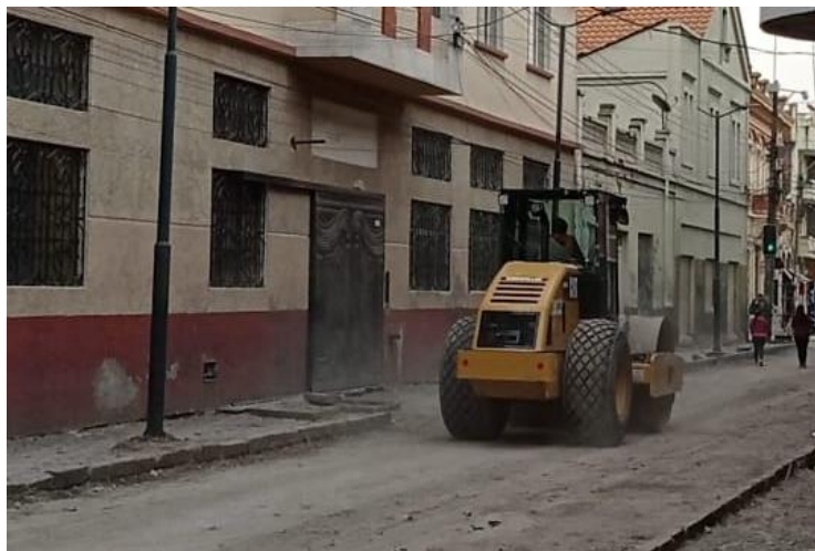
Figura 5-4: Compactación del material (subrasante, subbase, base)
