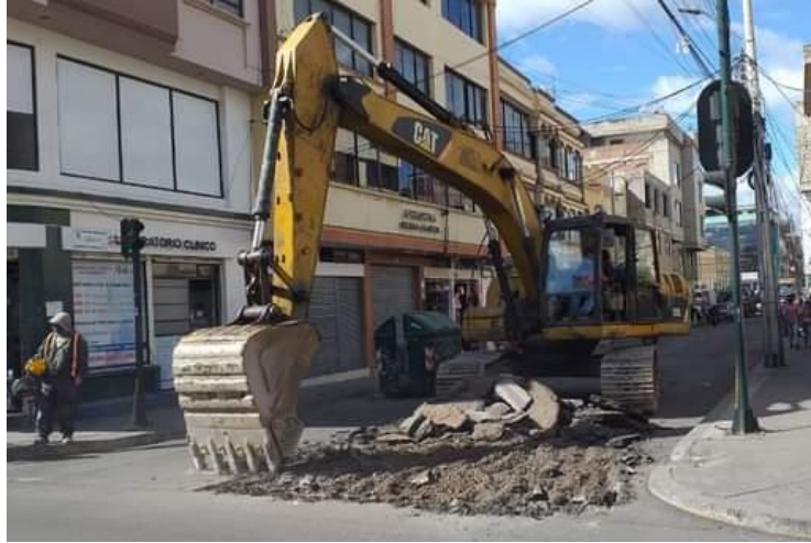
Figura 1-4: Levantamiento de la carpeta asfáltica antigua
