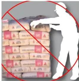
Los sacos ubicados por encima de abdomen del trabajador, no deben ser jalados para dar inicio al traslado de la carga, ya que esta técnica incorrecta de trabajo produce sobreesfuerzos y giros innecesarios de la espalda que inciden en la generación de lesiones.
