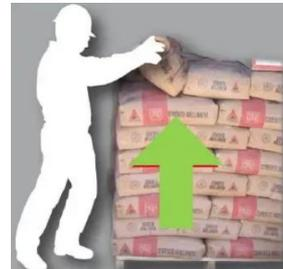
Los sacos ubicados por encima de abdomen del trabajador, deben ser levantados mediante la sujeción de uno de los extremos y luego acercarlos hacia el cuerpo y comenzar el traslado de la carga de forma segura.
