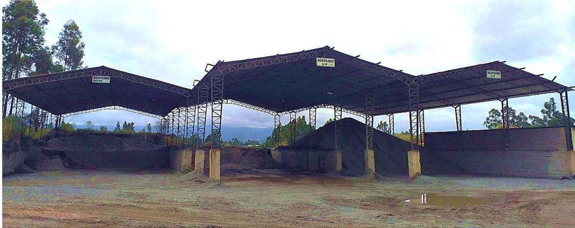
**Figura 3-3:** Galpones de apilamiento de agregados pétreos
