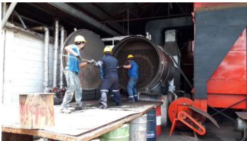
Figura 12-2. Mantenimiento del caldero actual
