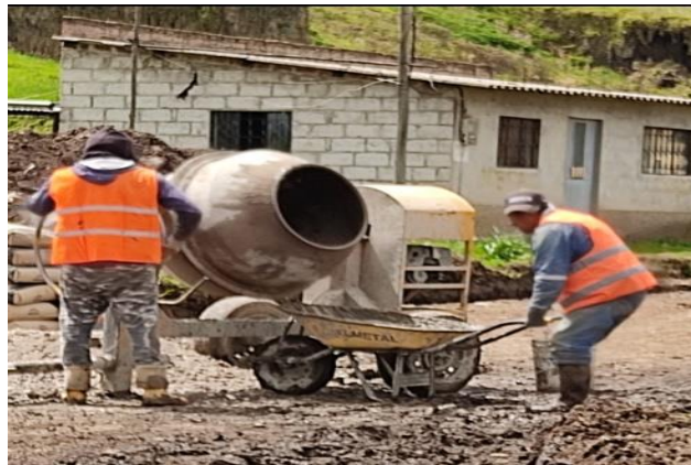
Figura 8-3. Puesto de trabajo desempeñado por los albañiles
